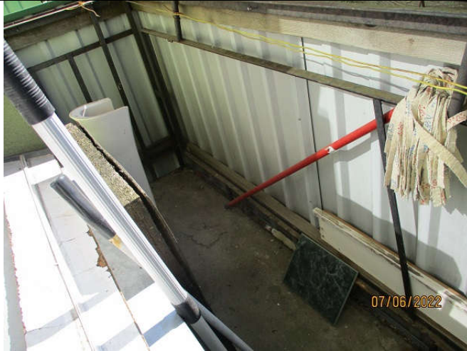
Foto nr. 1. Vaade rõdule. Vee äravool paneelilt on tõkestatud.
