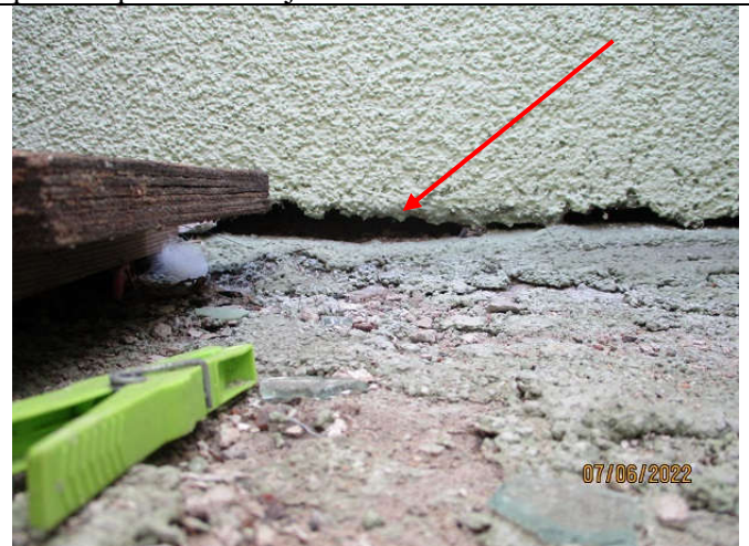
Foto nr. 6. Fassaadisoojustus ei ole tihedalt vastu pörandapaneeli. Läbijooksude võimalus.
